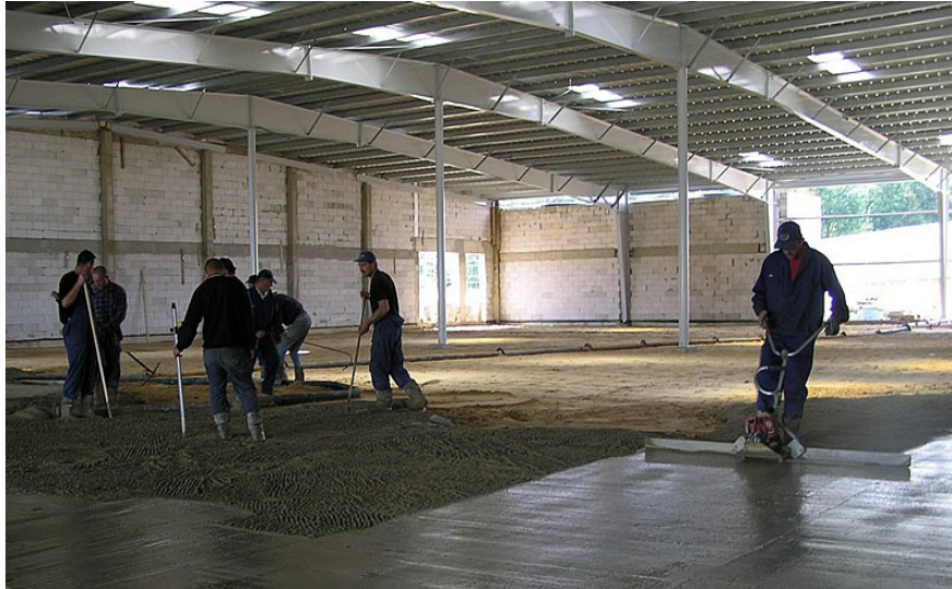
Rys.2.1. Wykonanie posadzki betonowej [24].
